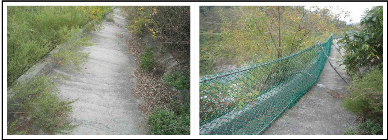
【그림 3.3.3】 배수시설 전경
